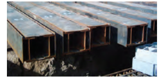
شکل ۲۹-۱ ب اتصال دو پروفیل با ورق
